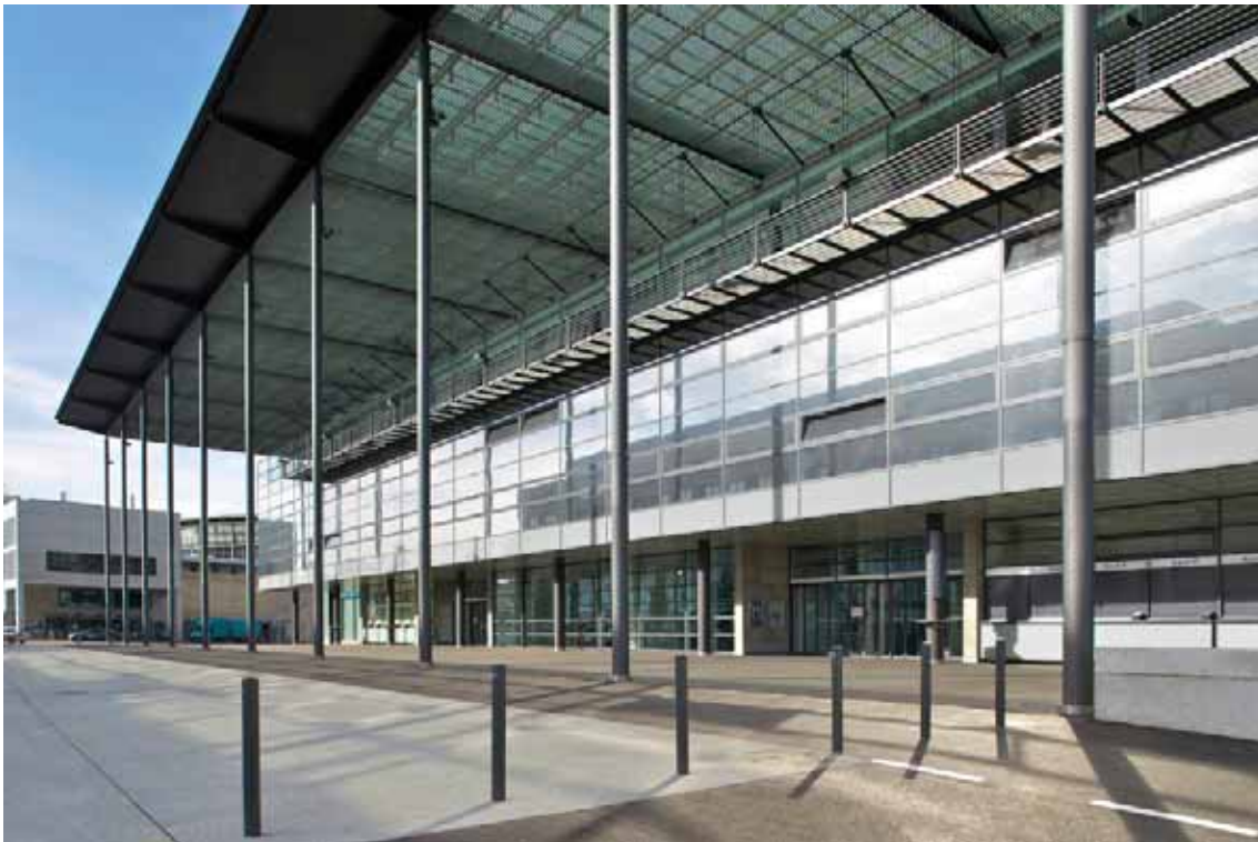
Messe Zürich | Anlieferungszone
